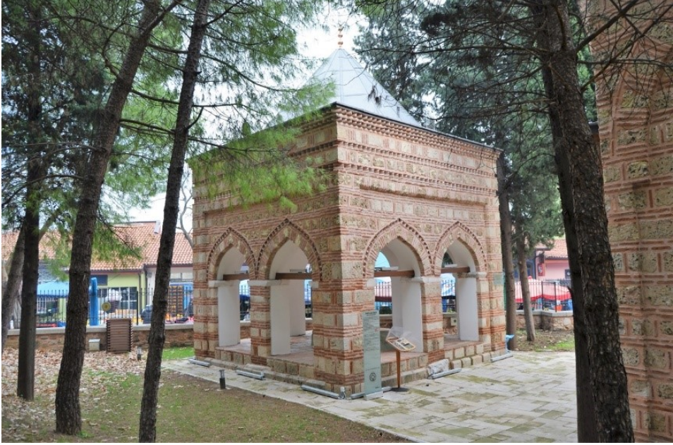
Resim 5. Saraylılar Türbesi, Bursa
