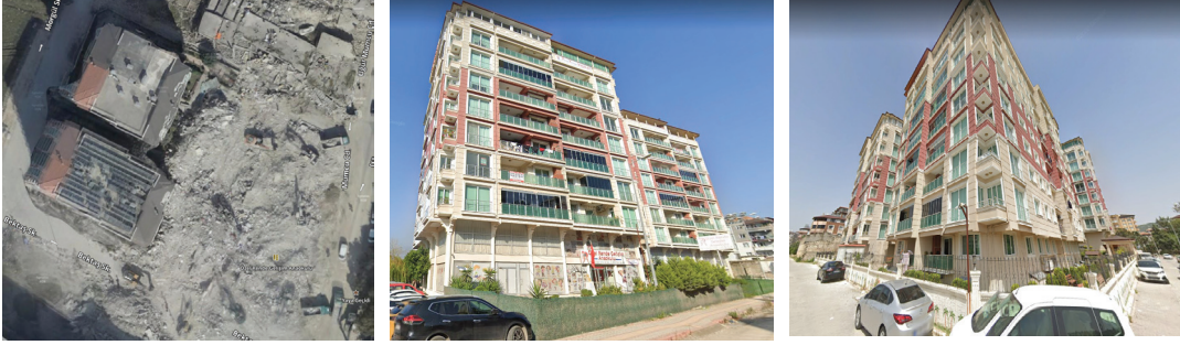
Şekil 11. Rende sitelerinde yumuşak kat durumu
