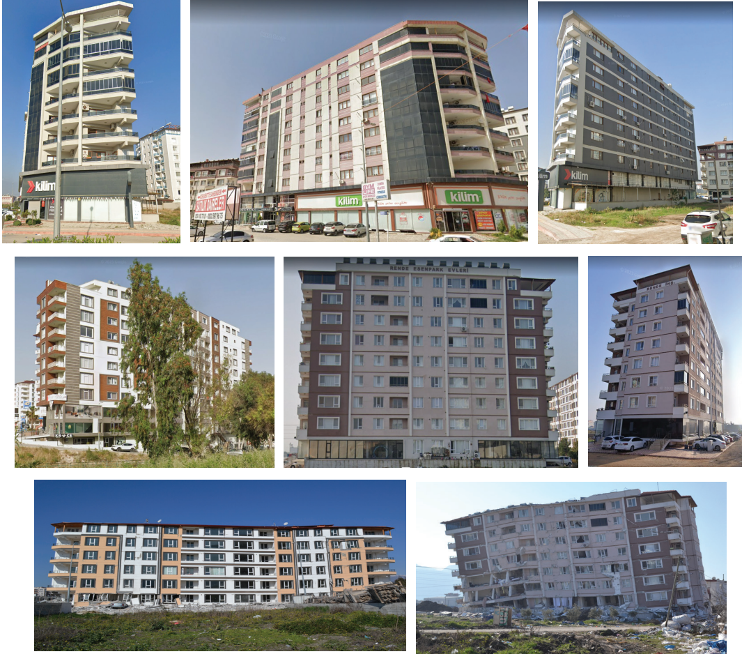
Şekil 19. Planda ince ve uzun izdüşüme sahip yıkılan ve hasar gören binalar
