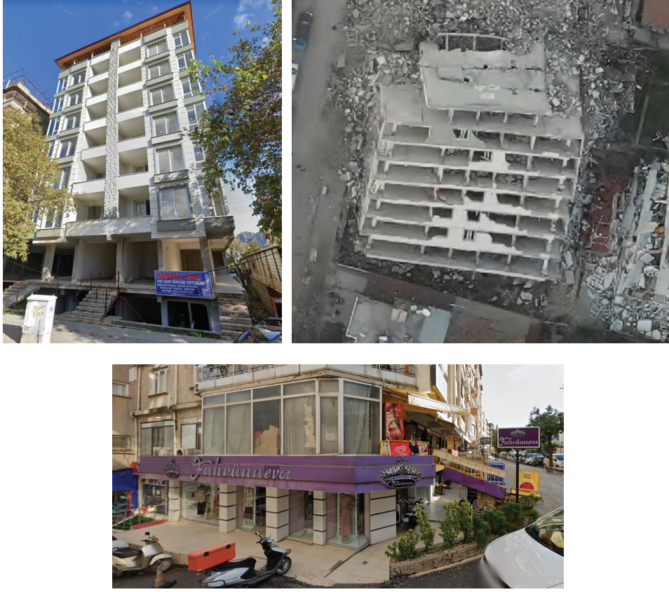
Şekil 13. Antakya’da bina bodrum oluşumu
