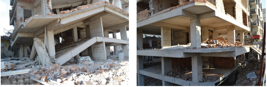
Şekil 1. 1999 öncesi yapılmış binalarda taşıyıcı sistem durumu ve kiriş süreksizliği örneği
