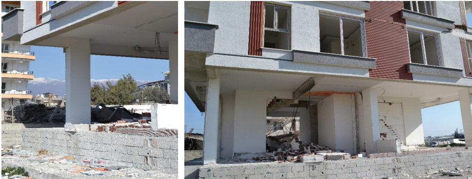
Şekil 2. Sürekli kiriş tasarımı yapılmayan taşıyıcı sistemler
