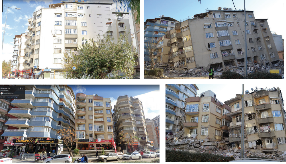
Şekil 20. Plan düzleminde ince uzun, çok katlı yapıda hasar
