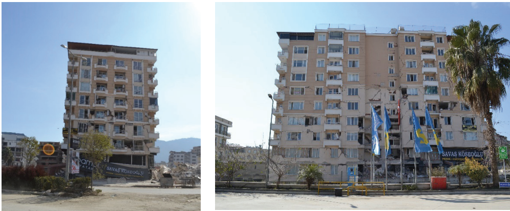
Şekil 9. Yumuşak kat mekanizması ve burulma deformasyonu gösteren bina
