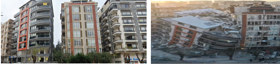
Şekil 21. Köşe parsellere yapılmış, ortogonal olmayan binaların deprem öncesi ve sonrası durumları
