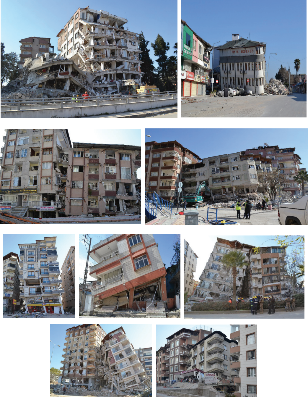
Şekil 10. Yumuşak kat deformasyonları ve hasarı
