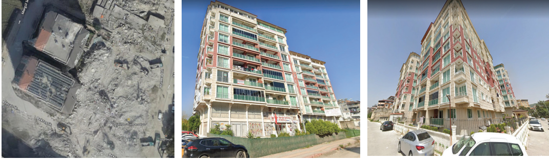
Şekil 11. Rende sitelerinde yumuşak kat durumu
