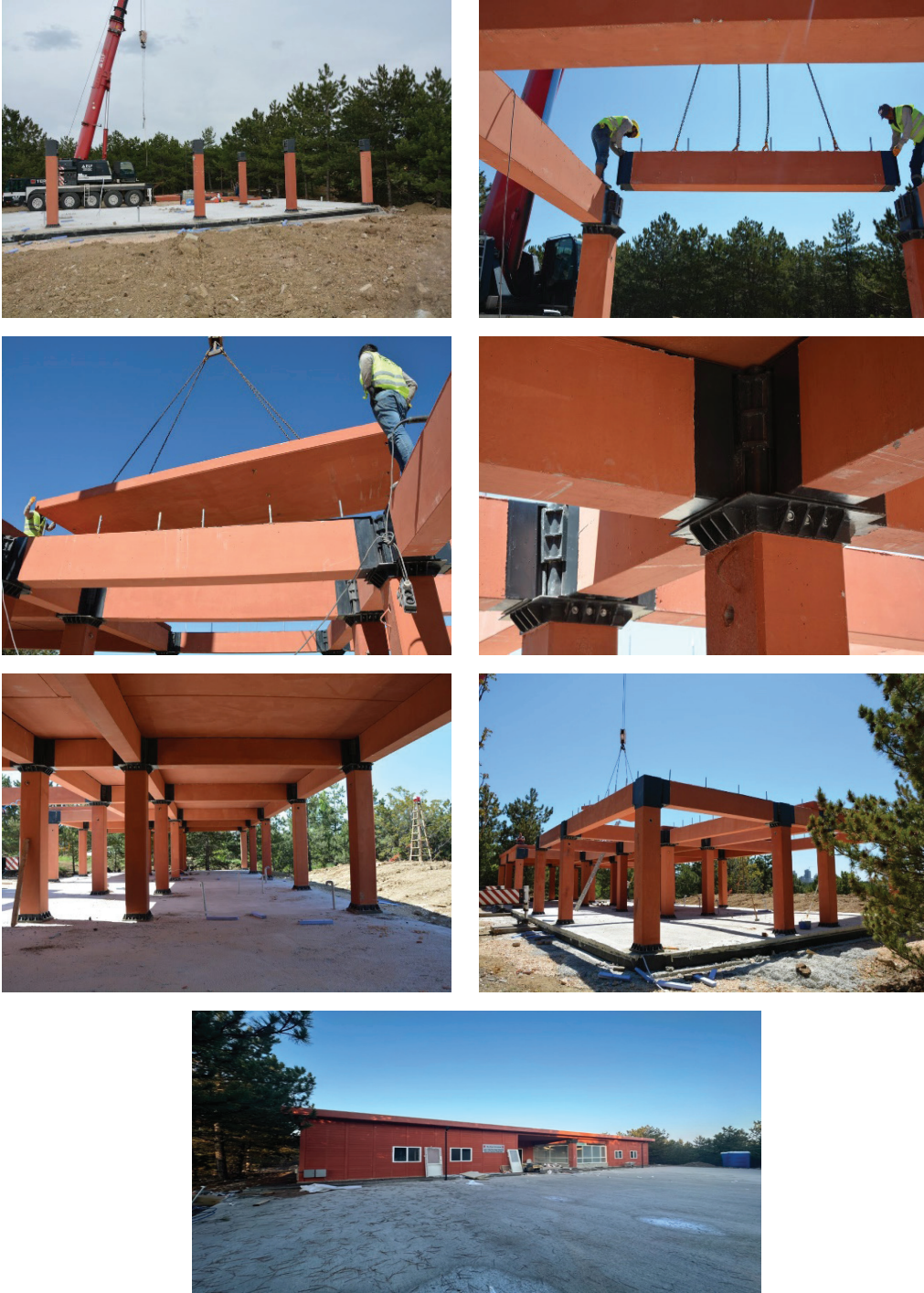
Şekil 15. İYA-bazlı jeopolimer beton ile üretilmiş tamamen sökülebilen konut inşaatı (Newton 2020 Ülke ödülü – Hacettepe Üniversitesi)
