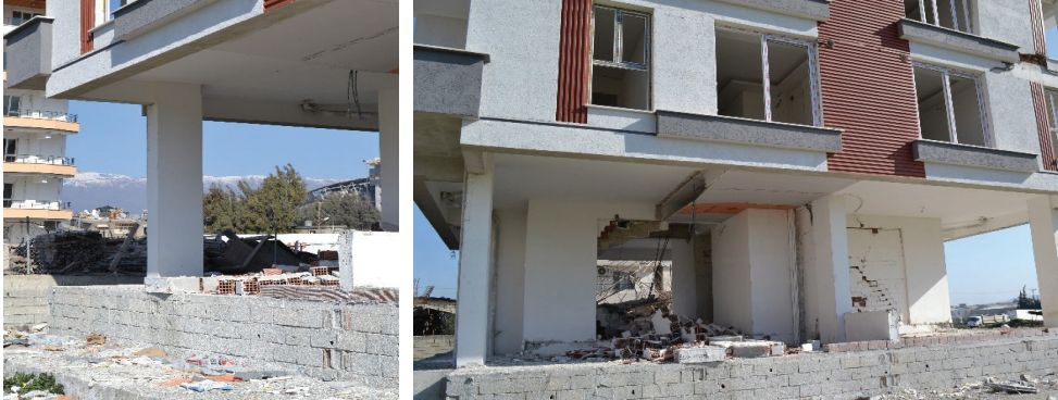
Şekil 2. Sürekli kiriş tasarımı yapılmayan taşıyıcı sistemler
