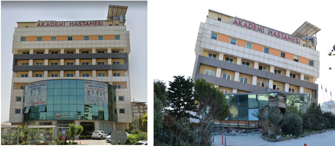
Şekil 12. yumuşak kat oluşumu ile yıkılan hastane binası
