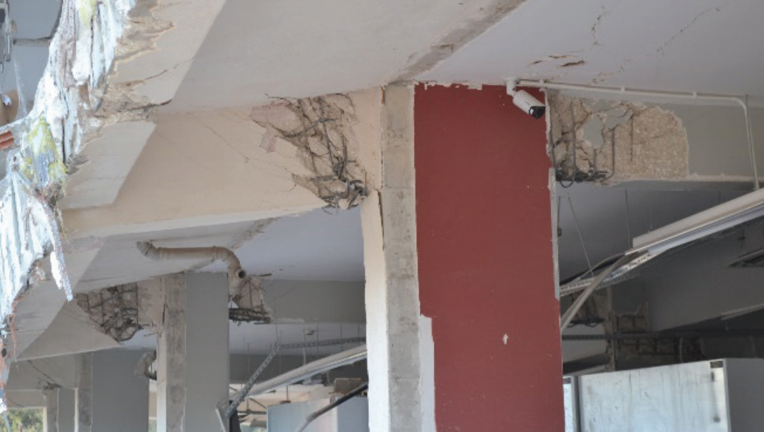
Şekil 4. Konsol kirişte mafsallaşma
