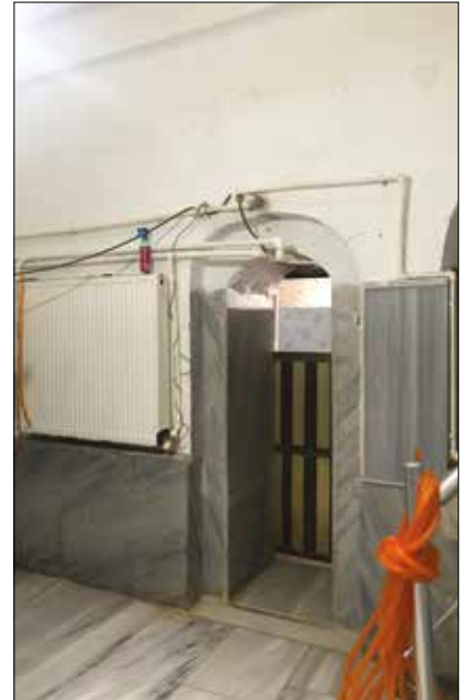
Fotoğraf 24. Hamam ılıklik kısmında yapılan fiziki müdahaleler ve nem sorunu / The physical interventions made in the hamam's tepid section and the humidity problem (Canitez, 2018)
