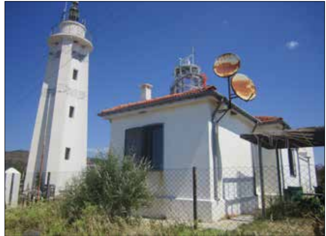
Figure 6. Sivrice Lighthouse in Ayvacık, Çanakkale had a light tower within the keeper's residence until 1945. Today it has an independent concrete light tower, (Başagaç 2012). / Çanakkale Ayvacık'ta bulunan Sivrice Deniz Feneri'nde ışık kulesi 1945 yılına kadar bakıcı konutu içerisinde yer almıştır. Bugün ise bağımsız beton bir ışık kulesi bulunmaktadır. (Başagaç 2012).
