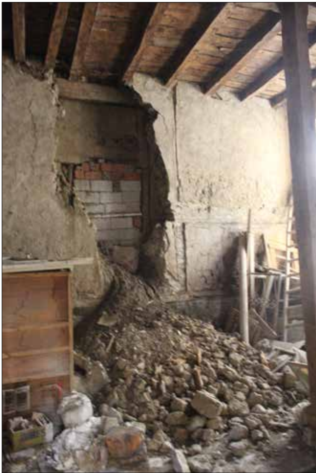
Fotoğraf 25. Yapının Güneydoğu duvarında bulunan ve çatıya kadar çıkan tahribat / The destruction at the southeastern wall which continues up to the roof (A.K. Ercan Arşivi)
