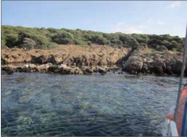
Figure 14a. Güneş Island Lighthouse in Ayvalık Balıkesir has been abandoned by its light keepers. The only man made element on the island, the lighthouse is a large building complex, composed of several structures and the only access to the island is through the rocks by the sea, (Başağaç 2012) and (Başağaç 2018: 112). / Balıkesir Ayvalık'ta yer alan Güneş Adası Deniz Feneri'nin bakıcıları alandan ayrılmıştır. Deniz feneri, çok sayıda yapıyı kapsayan geniş bir yapılar grubudur. Bu yapılar adada inşa edilmiş yegane öğelerdir. Adaya tek ulaşım deniz içindeki kayalar üzerinden sağlanmaktadır. (Başağaç 2012) ve (Başağaç 2018: 112).
