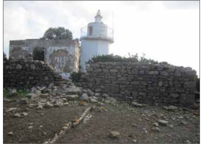
Figure 14b. Güneş Island Lighthouse in Ayvalık Balıkesir has been abandoned by its light keepers. The only man made element on the island, the lighthouse is a large building complex, composed of several structures and the only access to the island is through the rocks by the sea, (Başağaç 2012) and (Başağaç 2018: 112). / Balıkesir Ayvalık'ta yer alan Güneş Adası Deniz Feneri'nin bakıcıları alandan ayrılmıştır. Deniz feneri, çok sayıda yapıyı kapsayan geniş bir yapılar grubudur. Bu yapılar adada inşa edilmiş yegane öğelerdir. Adaya tek ulaşım deniz içindeki kayalar üzerinden sağlanmaktadır. (Başağaç 2012) ve (Başağaç 2018: 112).
