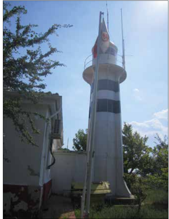
Figure 10. Çanakkale Kepez Lighthouse, with an iron light tower, (Başagaç 2012) and (Başagaç 2018: 111). / Çanakkale Kepez Deniz Feneri, demir bir ışık kulesine sahiptir. (Başagaç 2012) ve (Başagaç 2018: 111).
