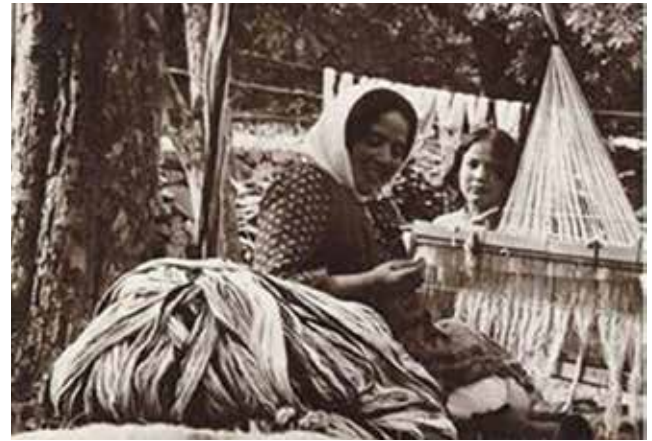
Fotoğraf 10 - Çözgü ipliklerinin düzenlenmesi / Arrangement of warp threads (Fotoğraf için kaynak kişi / Source for photo: Temel MELETLİ) (Fotoğrafta yer alan çözgü ipliği ustası / Master of the warp yarn in the photo: Havva AKGÜN) (Yıl / Year: 1976-1977)
