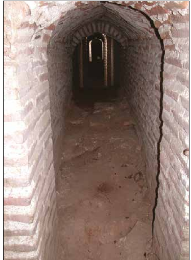
Fotoğraf 25 - Kubbeler arasındaki beşik tonozla örtülü dehliz / The gallery with barrel vault between the domes.
