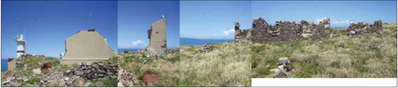
Figure 7. Oğlak Island Lighthouse in Foça, İzmir is a building complex with two large residences, a separate light tower and it is the only man made structure on an island which has turned into a cultural landscape, (Başagaç 2012) and (Başagaç 2018: 114). / İzmir Foça'da yer alan Oğlak Adası Deniz Feneri geniş, iki adet bakıcı konutu ve bağımsız bir ışık kulesi ile bir yapılar grubudur. Oğlak Adası'nda inşa edilmiş tek yapı grubu olarak bugün bir kültür peyzajına dönüşmüştür. (Başagaç 2012) ve (Başagaç 2018: 114).
