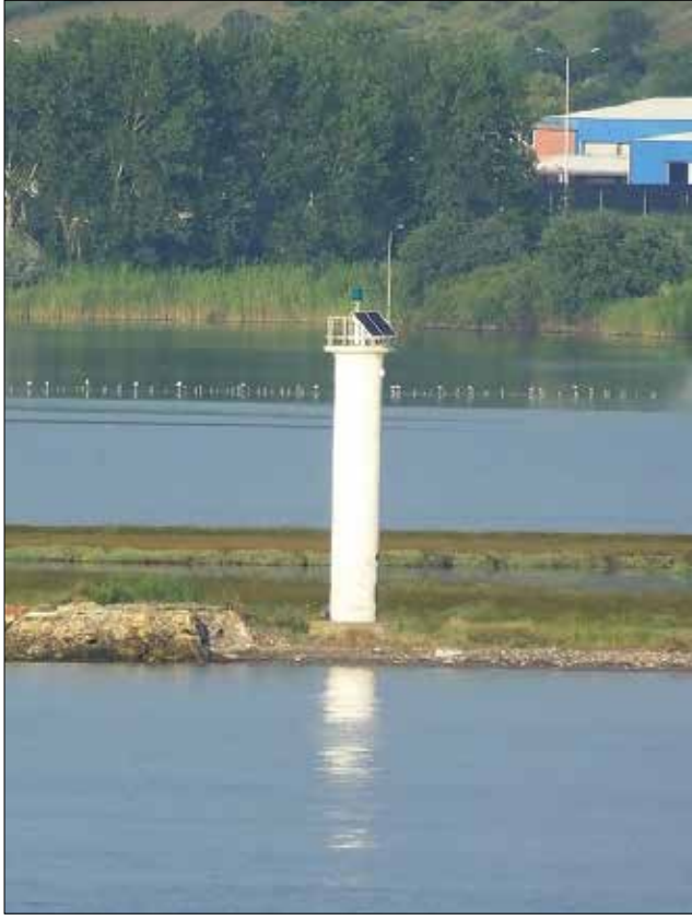
Figure 4. Çardak Lighthouse in Gelibolu, Çanakkale is a single tower lighthouse without a keeper's residence, (Başagaç 2012). / Çanakkale Gelibolu'da yer alan Çardak Deniz Feneri, bakıcı konutu olmayan tek kuleli deniz fenerlerinin bir örneğidir. (Başagaç 2012).
