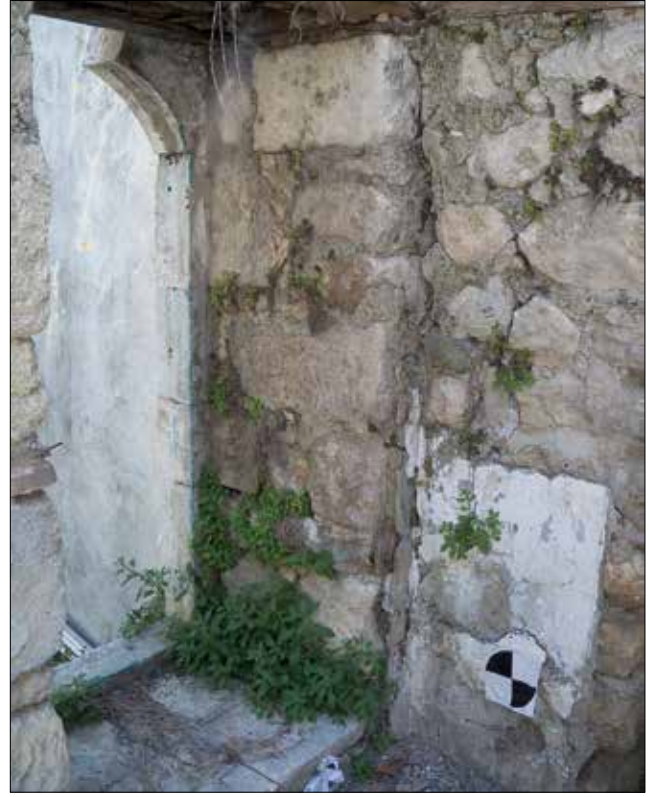
Fotoğraf 16. Duvar örgü sisteminin ayrıştığı köşe (Yazar, 2016). / Seperate wall bonding.
